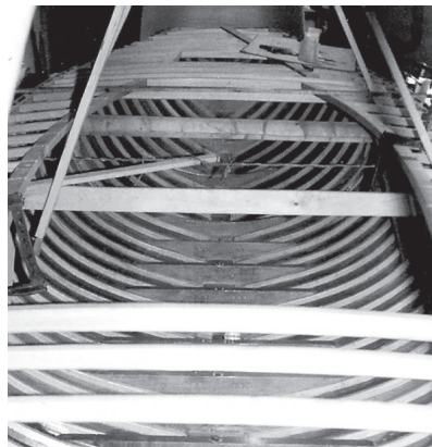
Däcksbalakr och karvel monterade
