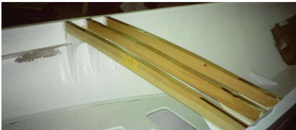
Mastbalkar på plats och invändig målning pågår.
