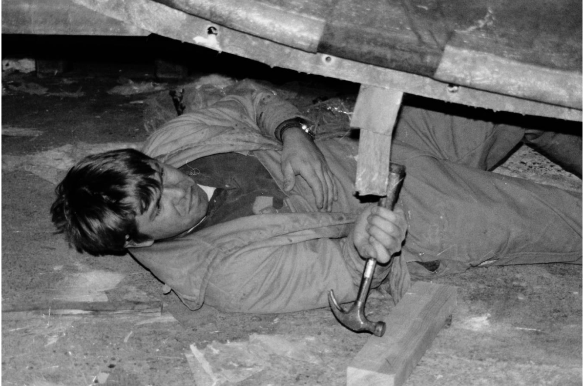
Det såg rätt våldsamt ut när Lasse började banka för att få loss skrovet från formen...
