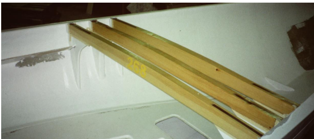
Mastbalkar på plats och invändig målning pågår.
