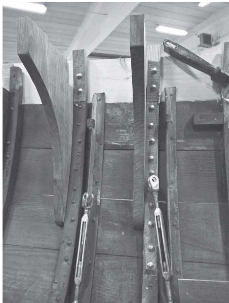
Ny del i bordläggning, nya delar av spant och nya spantknän monterade på styrbordssidan.
