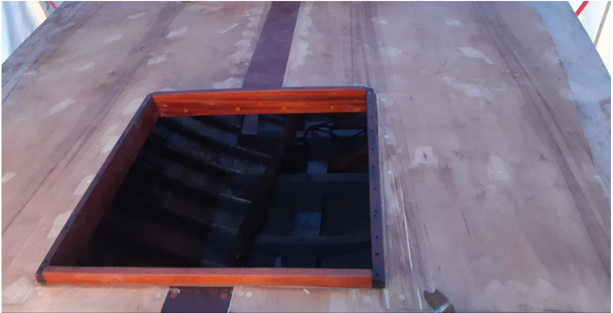
Renovering av lucksargar
