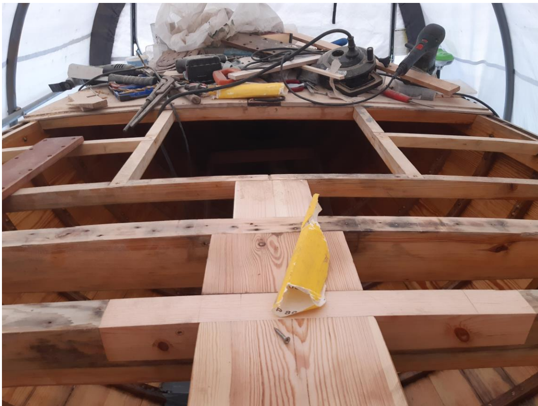
Renovering av mastpartiet
