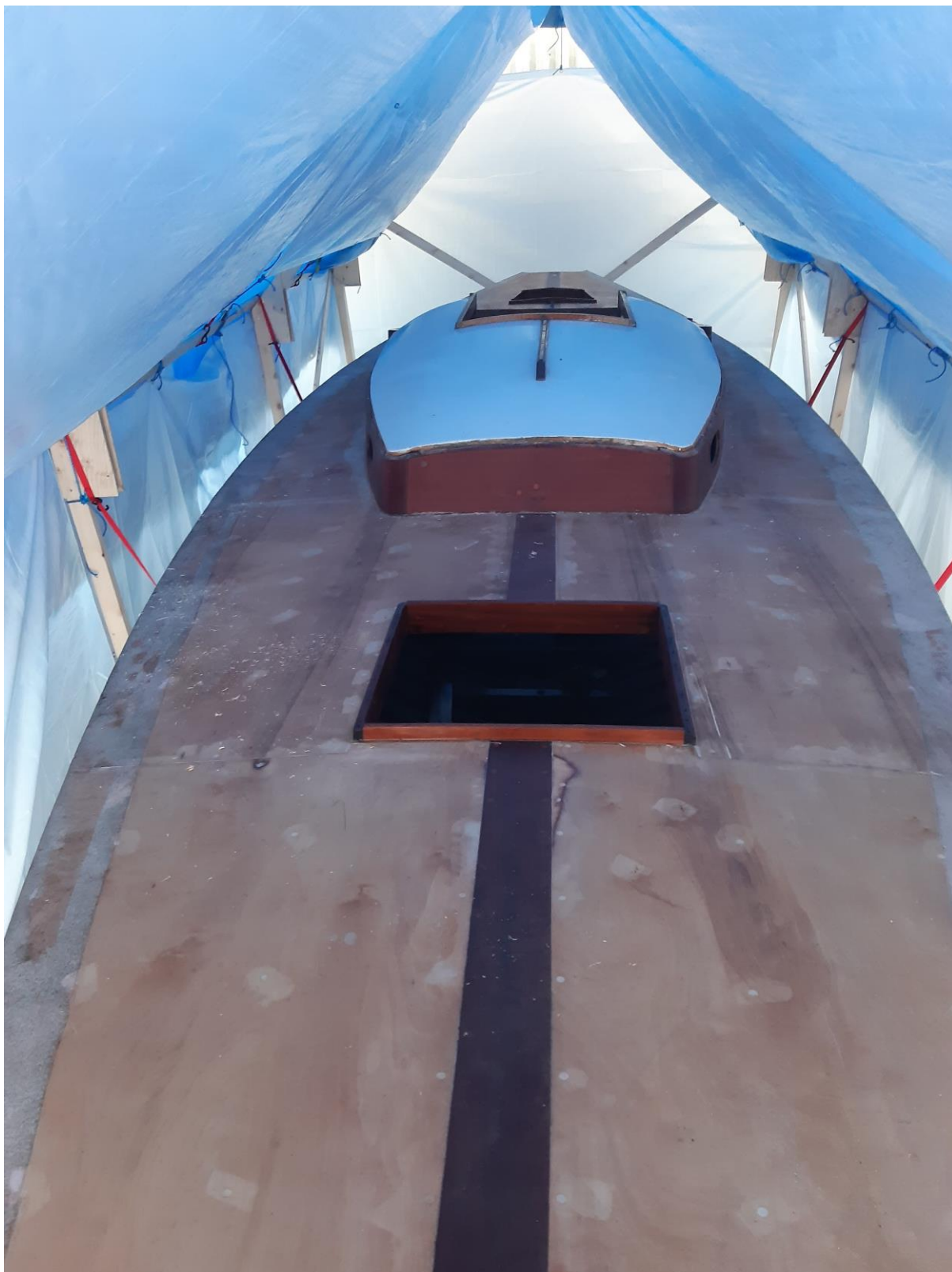
Nya däck under arbete.
